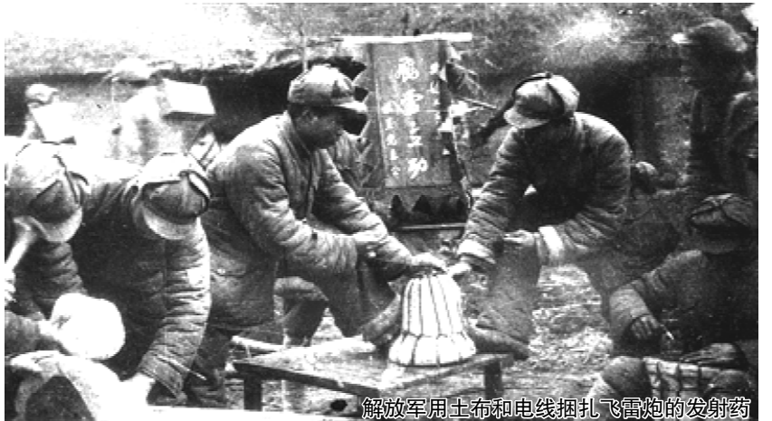
解放军用土法和电线捆扎飞雷炮的发射筒
